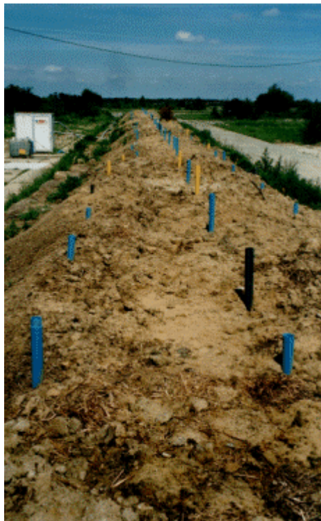
Rys. 1.15. Wentylacja bierna gruntu przy użyciu perforowanych lanc
