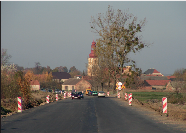
Ryc. 10. Widok na wieżę kościoła w Makowicach – finał modernizacji drogi nr 401 (fot. O. Mycak, 2010)
