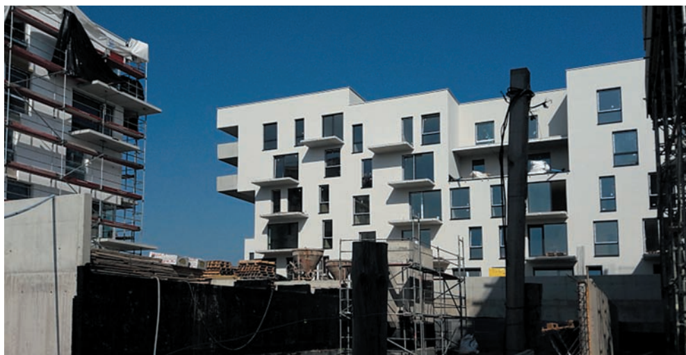
Ilustracja 66. Widok kwartału w budowie od pasażu A. Radinga. Zdjęcie: autor
