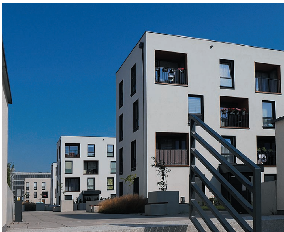
Ilustracja 62. Wejście na dziedziniec wewnętrzny urządzone na stropodachu garażu. Zdjęcie: autor
