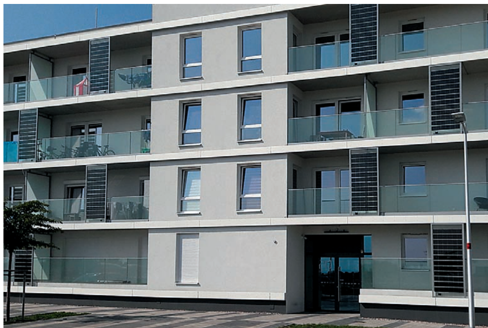
Ilustracja 105. Panele fotowoltaiczne na elewacji południowej, ul. Brzozy. Zdjęcie: autor
