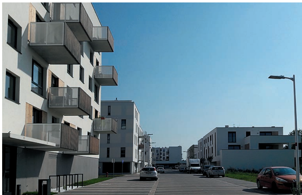
Ilustracja 121. Po prawej budynki kooperatyw z oferty nr 10 (w budowie) i 11 (na pierwszym planie). Zdjęcie: autor
