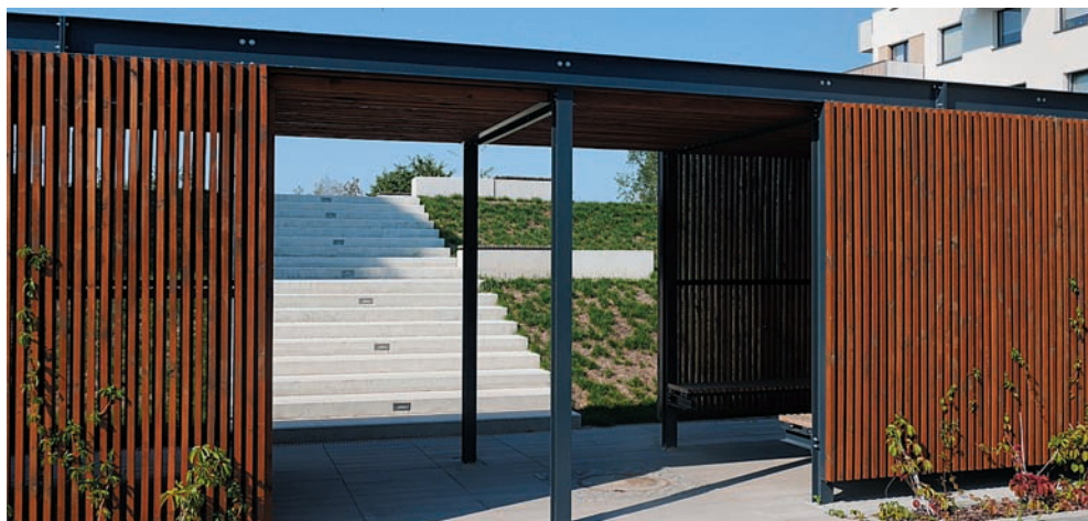
Ilustracja 69. Wejście na dziedziniec kwartału od ul. A. Frydeckiego. Zdjęcie: autor
