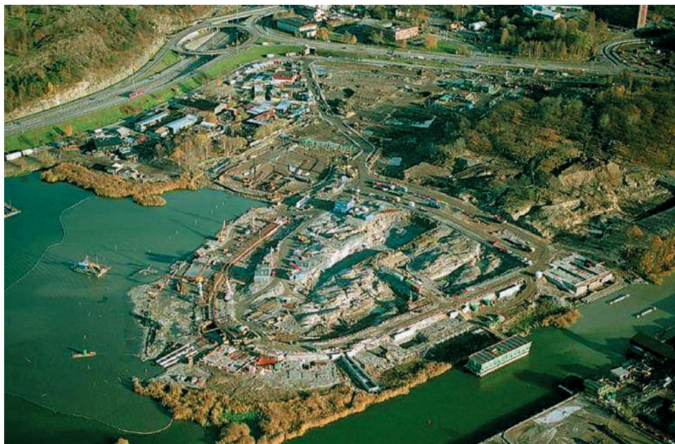
Ilustracja 30. Hammarby Sjöstad, Sztokholm, oczyszczanie terenu przemysłowego, 1998 r. Źródło: materiały archiwalne organizatorów projektu Nowe Żerniki
