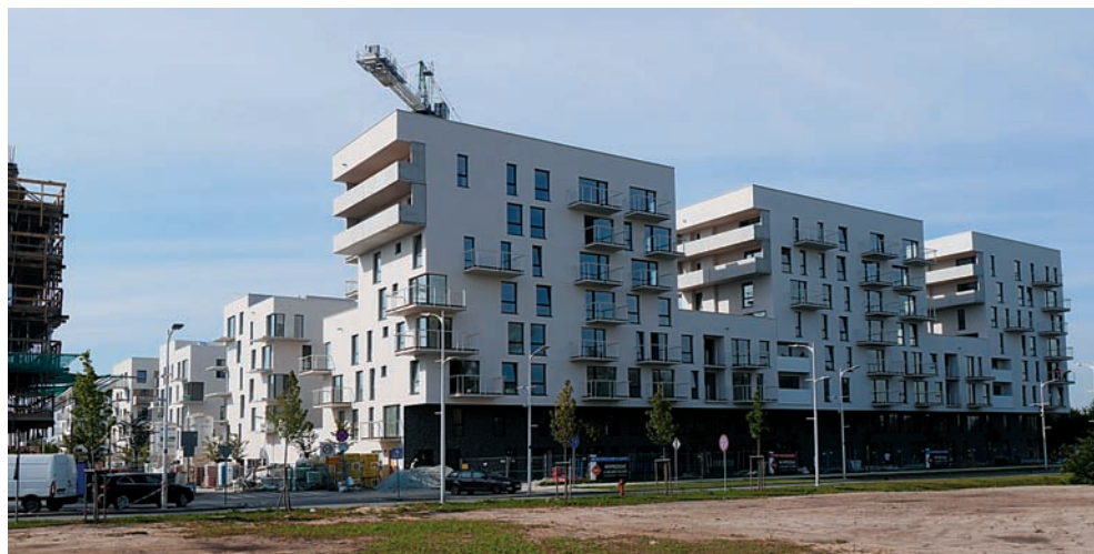
Ilustracja 65. Kwartal w budowie, widok od strony skrzyżowania al. Architektów i ul. A. Frydeckiego. Zdjęcie: autor
