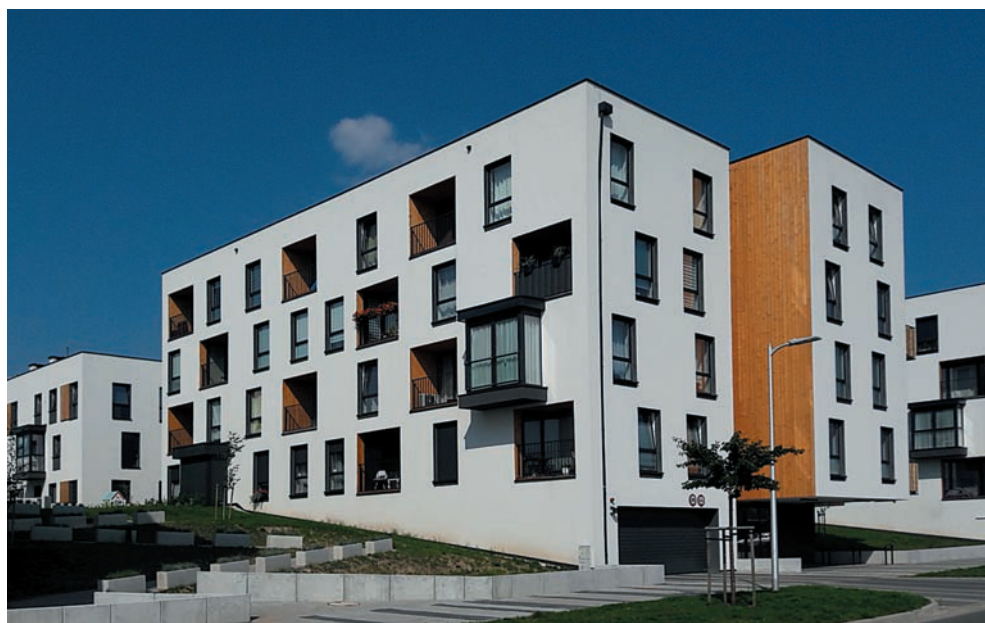
Ilustracja 98. Widok kwartału od południa, ul. Brzozy. Zdjęcie: autor. Widoczne elewacje boczne z aplikacjami z drewna, loggiami i wykuszami. Widoczna także pochylnia prowadząca na wspólny teren zielony na stropodachu nad garażem. W parterze od ulicy wejścia do budynków i wjazdy do garażu
