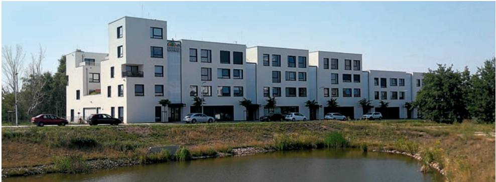
Ilustracja 124. Budynek wielorodzinny, widok ponad zbiornikiem retencyjnym na skwerze Scharouna. Zdjęcie: autor
