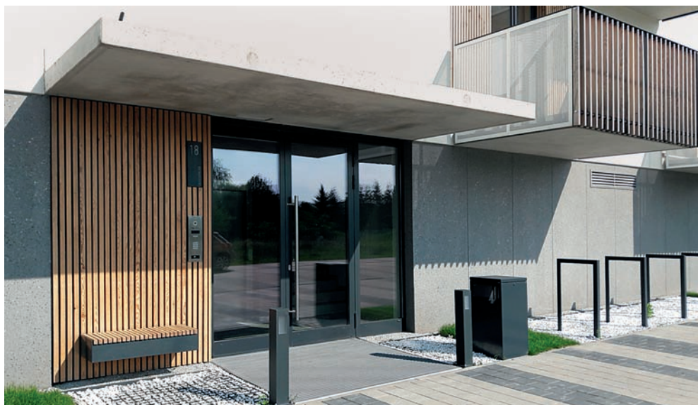
Ilustracja 73. Strefa wejściowa do budynku zachodniego (w poziomie terenu), ul. H. Lauterbacha. Zdjęcie: autor. Widoczne elementy małej architektury: ławka, pojemniki na śmieci, stojaki na rowery oraz oświetlenie zewnętrzne. Na spójną estetykę zespołu wpływa zastosowanie takiego samego motywu z drewna
