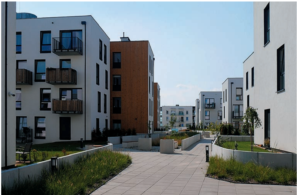
Ilustracja 101. Zagospodarowanie terenu zielonego na stropodachu garażu. Komunikacja, oświetlenie, ławki, wydzielone ogródki przydomowe dla mieszkań na poziomie pierwszego piętra. Zdjęcie: autor
