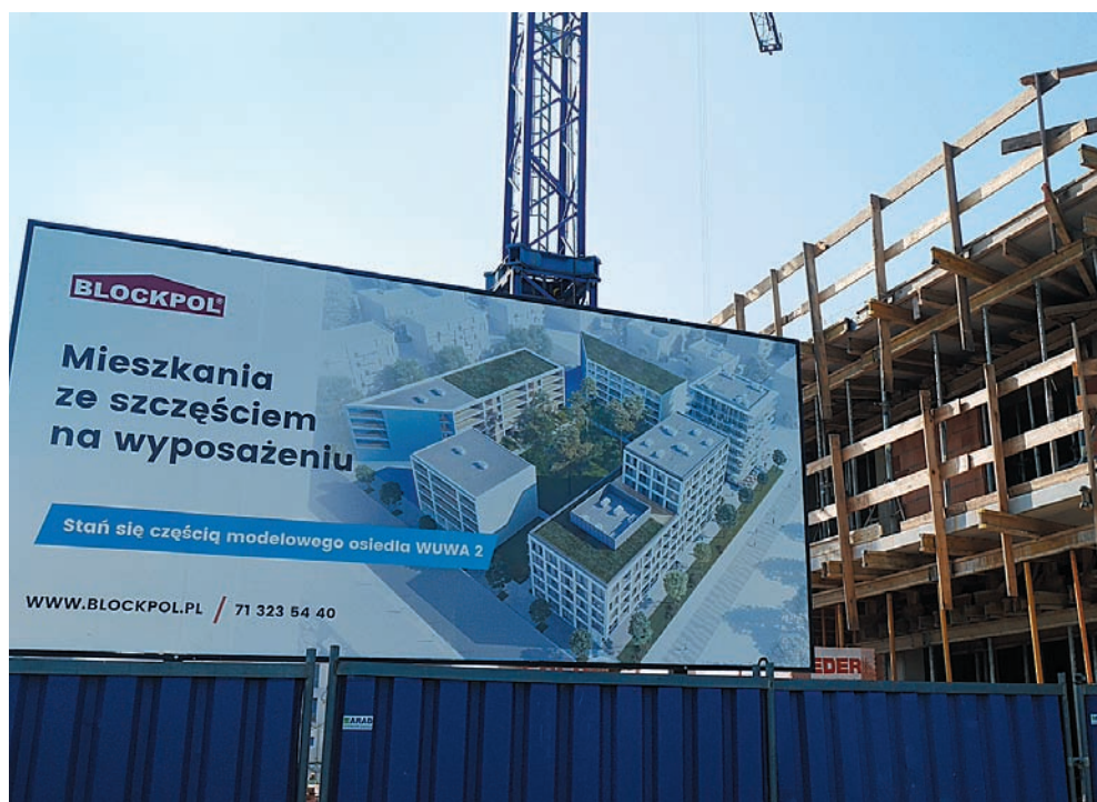
Ilustracja 75. Budowa kwartału z banerem reklamowym na ogrodzeniu budowy. Zdjęcie: autor
