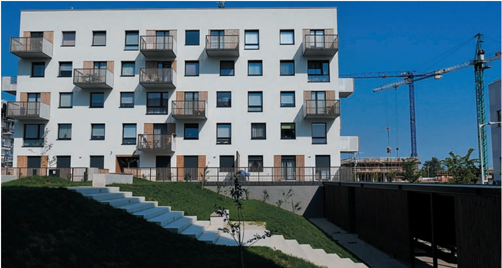
Ilustracja 70. Widok budynku wschodniego kwartału od strony zachodniej oraz wejścia na wewnętrzny dziedziniec – zielony taras na poziomie +1. Zdjęcie: autor. W tle budowa kwartału nr 4, części wschodniej (oferta nr 4)
