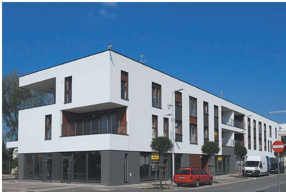
Ilustracja 114. Widok południowo-zachodniego narożnika, w parterze lokal usługowy przeznaczony na kawiarnię, w tle kolejne budowy. Zdjęcie: autor
