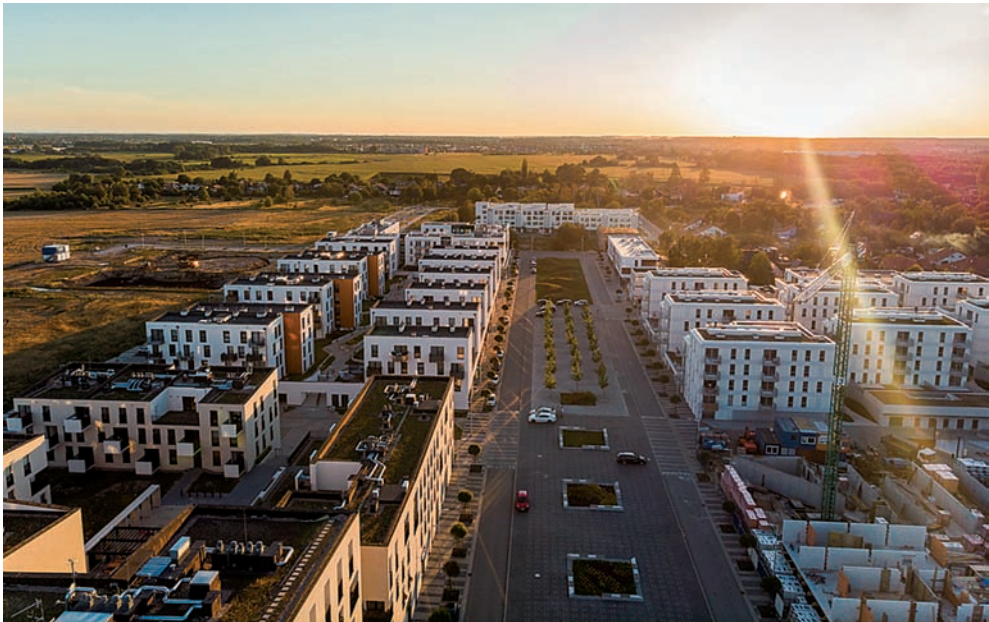
Ilustracja 55. Zachód słońca nad budowanym osiedlem Nowe Żerniki. Zdjęcie: Maciej Lulko. Na zdjęciu widoczna oś wschód–zachód osiedla z reprezentacyjną zielenią – ul. Barskich
