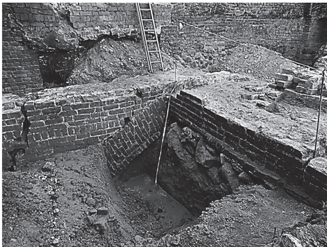
Il. 10. Południowy fundament łukowy (fot. J. Albrecht)
