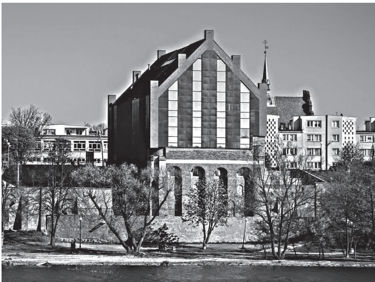
Il. 3. Widok po odbudowie (fot. J. Albrecht)
