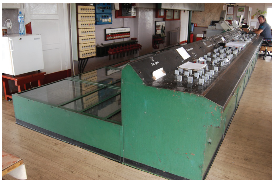
Il. 5. Nastawnica suwakowa czterorzędowa z 1943 r., poziom górny (Iława). Stan w 2012 r. (fot. P. Microśławski)
