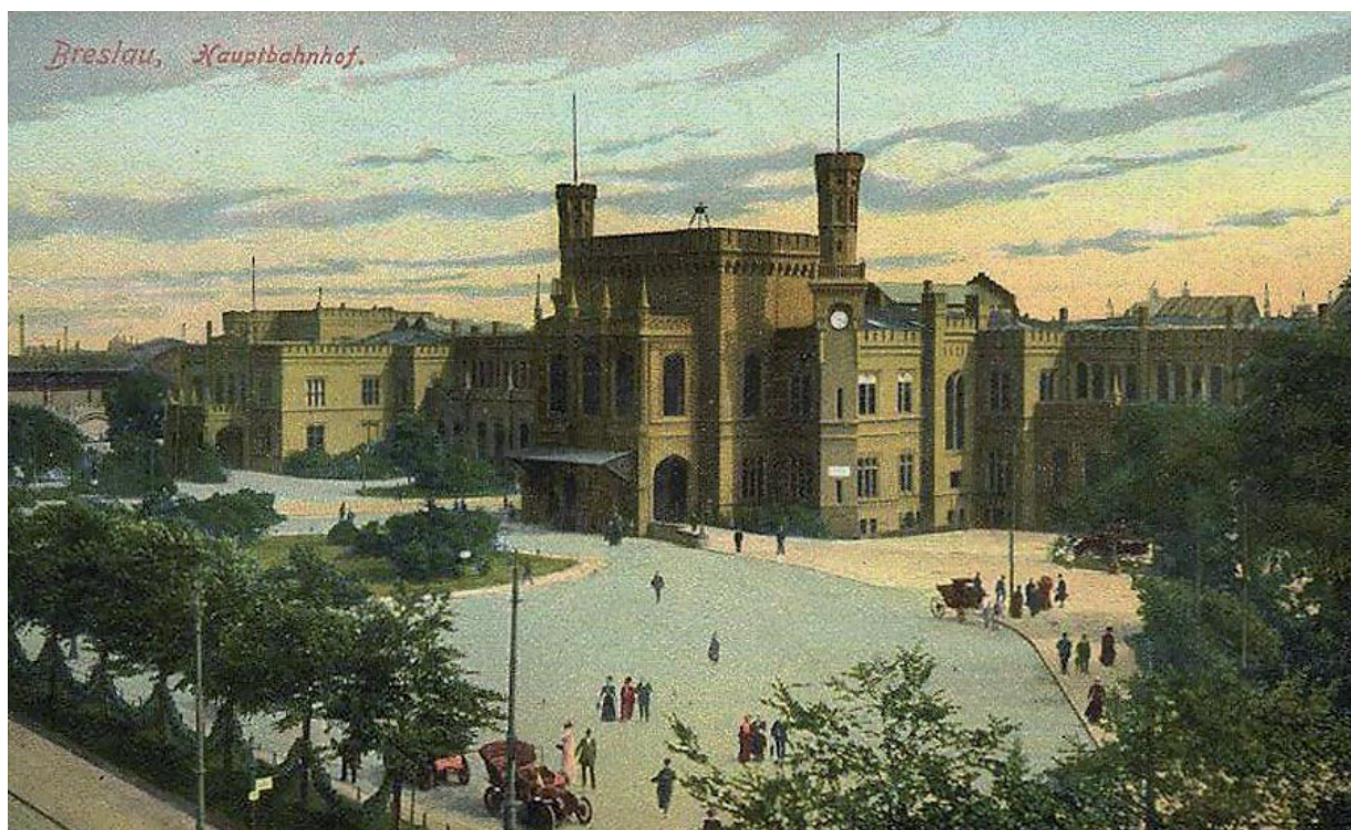
Il. 3. Wrocławski Dworzec Główny (Hauptbahnhof Breslau) – plac przed dworcem przebudowany w 1905 r. w celu usprawnienia narastającego ruchu powozów i automobili [69]
