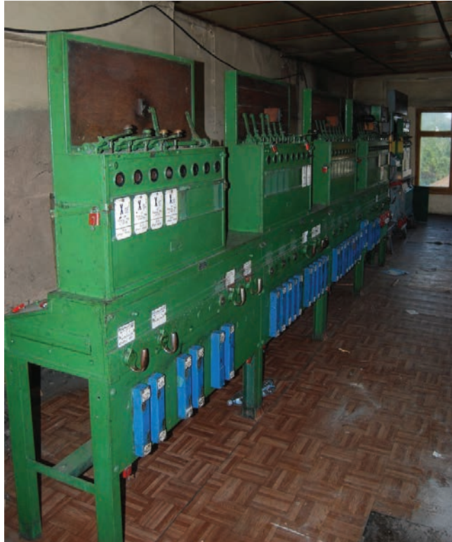
Il. 2. Nastawnica mechaniczna kluczowa typu P46 z 1954 r. (Skierniewice). Stan w 2015 r. (fot. P. Mierosławski)
