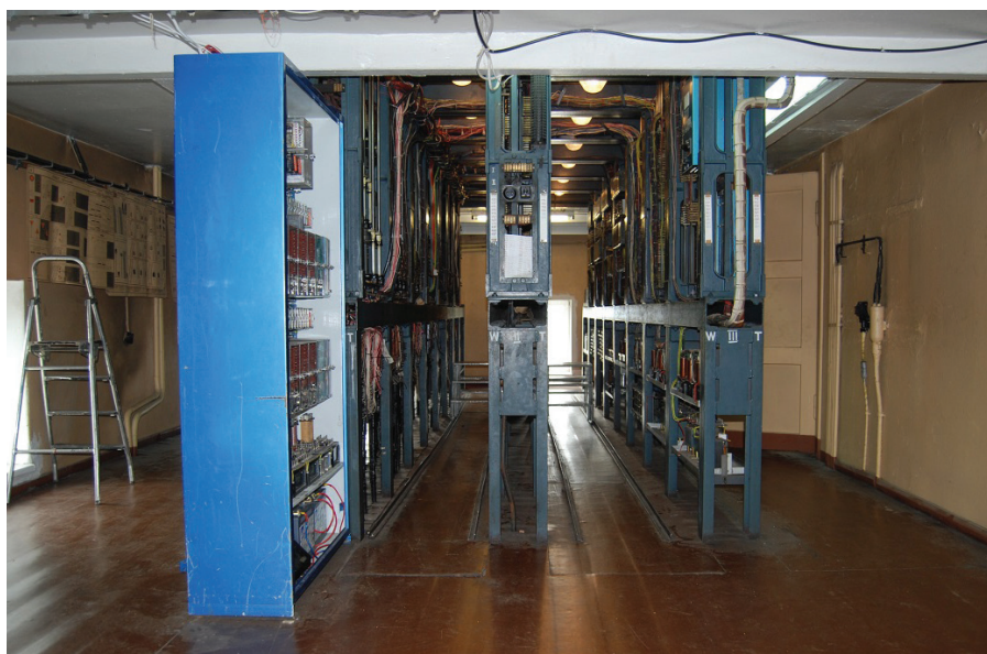
Il. 6. Nastawnica suwakowa czterorzędowa z 1943 roku, poziom dolny (Iława). Stan w 2012 r. (fot. P. Microśławski)
