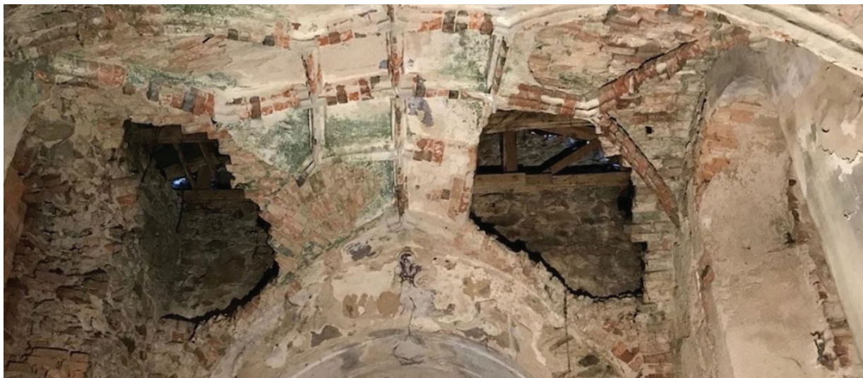
Il. 4. Destrukt sklepienia nad prezbiterium (fot. I. Krawiec, sierpień 2018)
