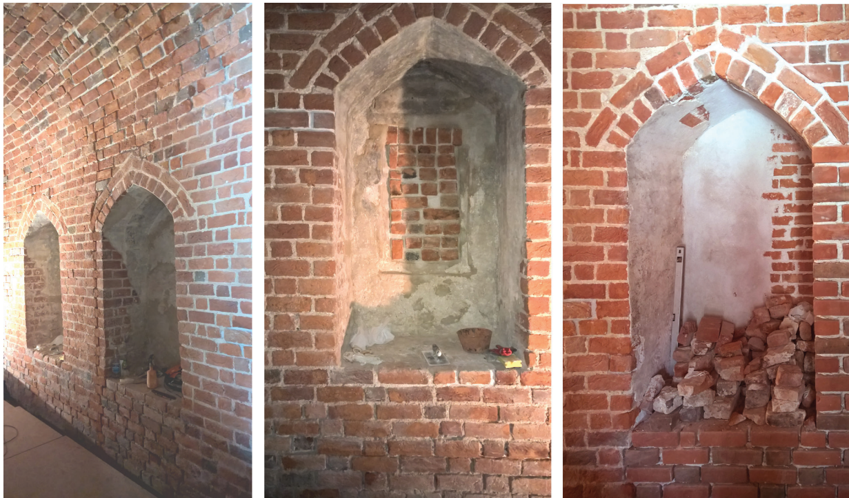
II. 4. Pozostałości ściany najstarszej latryny mogilskiej. Wnęki I i II widoczne w pomieszczeniu klauzury, 2019 (fot. L. Smirnowa)
