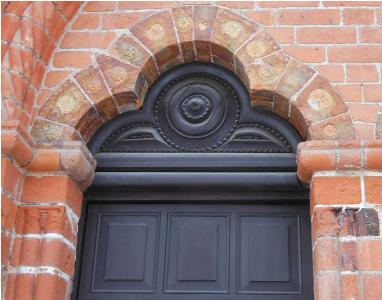
Il. 8. Trójlistne zamknięcie biforyjnego przejścia portalu, dekoracja klinców, głowic ościeży i środkowego filara (fot. M. Doroz-Turek, 2018)
