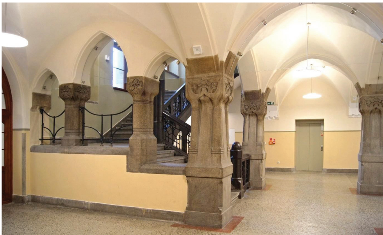
Il. 9. Gmach Wydziału Architektury Politechniki Wrocławskiej. Stan holu na parterze po przebudowie. Nowa winda i szklane kurtyny przeciwpożarowe. Kolorystyka ścian zgodnie z wynikami badań i analizami A. Gryglewskiej (fot. A. Krupa, 2019)
