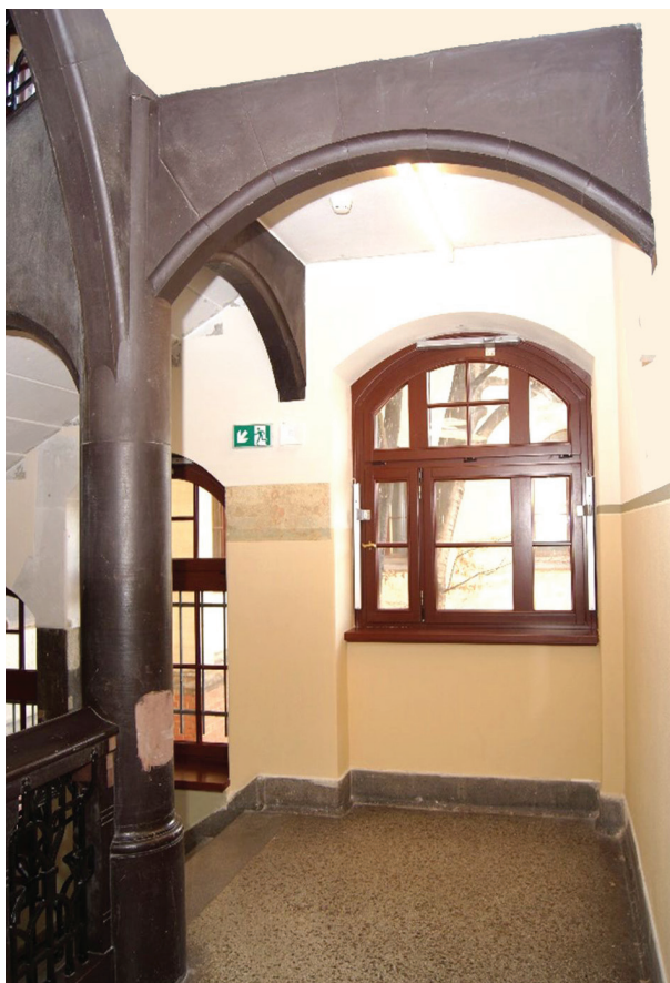
Il. 11. Gmach Wydziału Architektury Politechniki Wrocławskiej. Klatka schodowa na parterze po rewaloryzacji. Nowe zespolone okna z systemem siłowników przeciwpożarowych. Na filarze zachowany fragment fryzu szablonowego (fot. A. Krupa, 2019)
