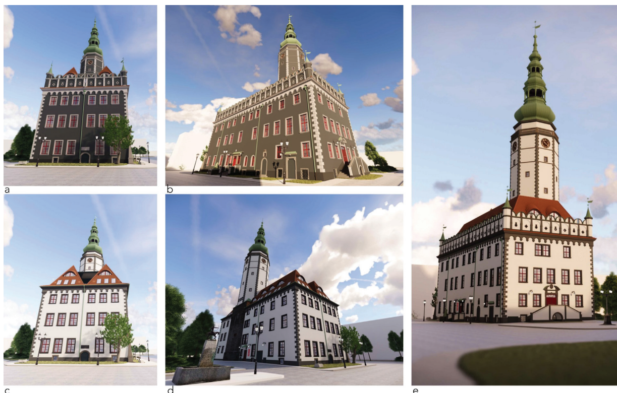
Il. 7. Strzelin, ratusz, wizualizacje przedstawiające poszukiwania optymalnego zwieńczenia i kolorystyki obiektu: a), b) ciemnoszare tło z bielonym detalem, c), d) próba odstąpienia od realizacji koronującej attyki, e) przyjęta realizacyjna kolorystyka ciemnego detalu na jasnym tle (konceptcja i wizualizacje R. Karnicki [20])
