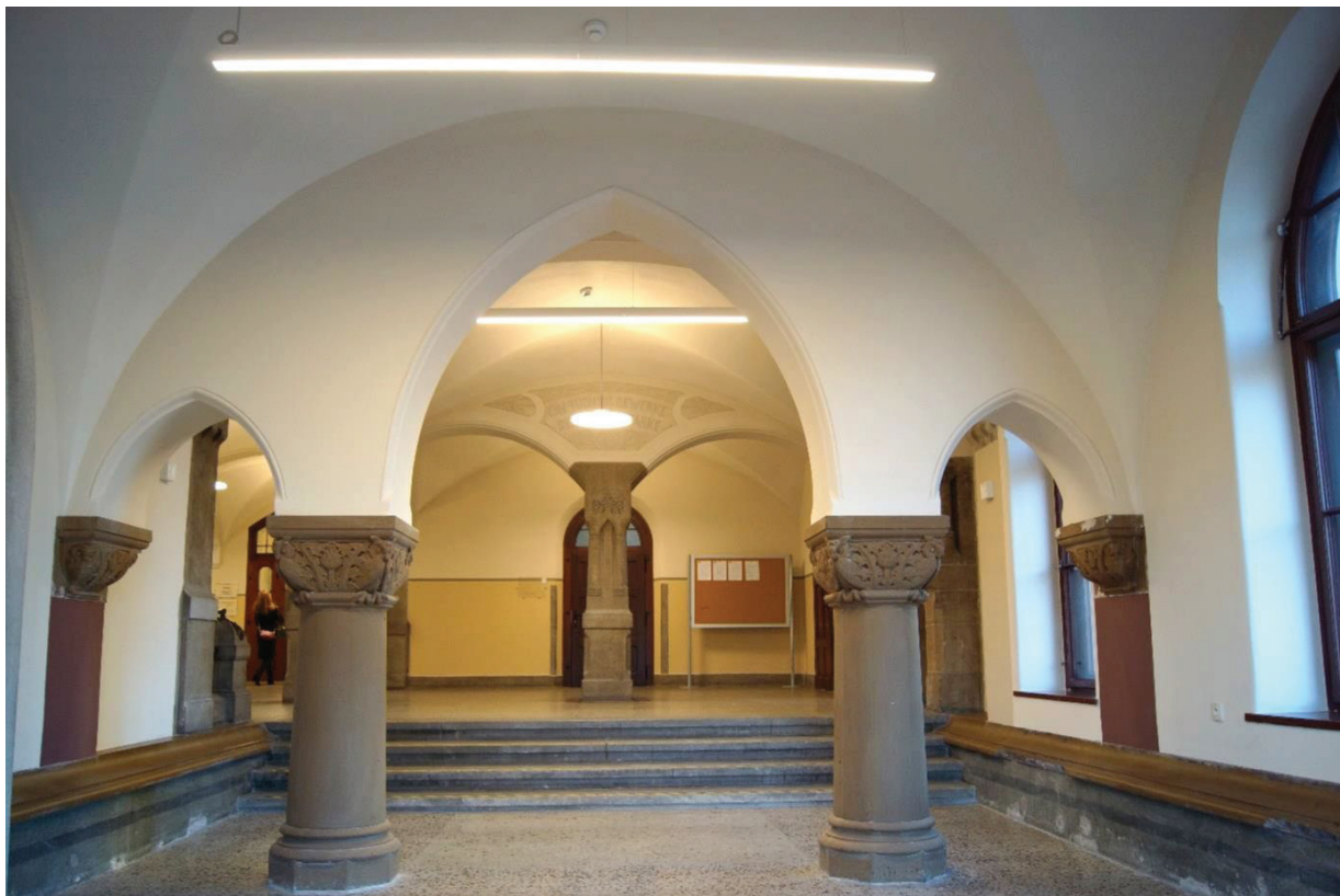
Il. 10. Gmach Wydziału Architektury Politechniki Wrocławskiej.
