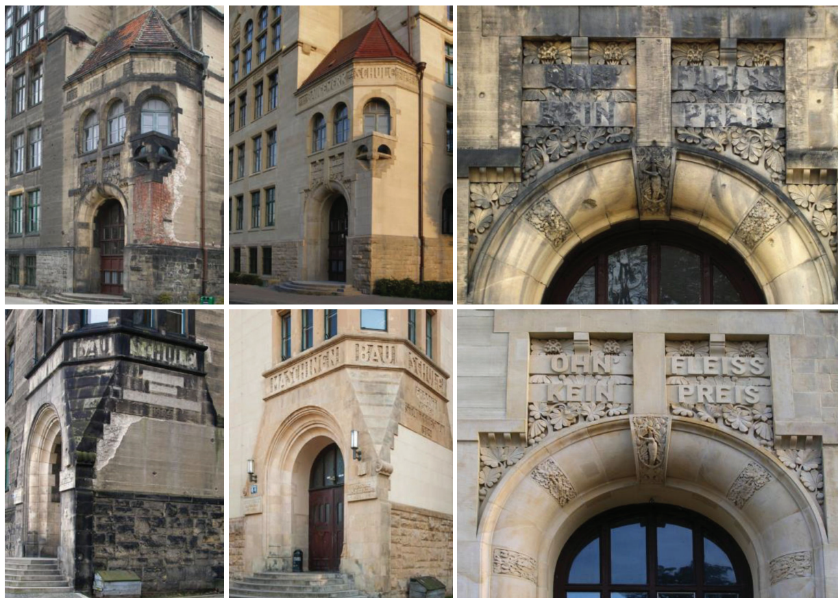
Il. 6. Gmach Wydziału Architektury Politechniki Wrocławskiej.
