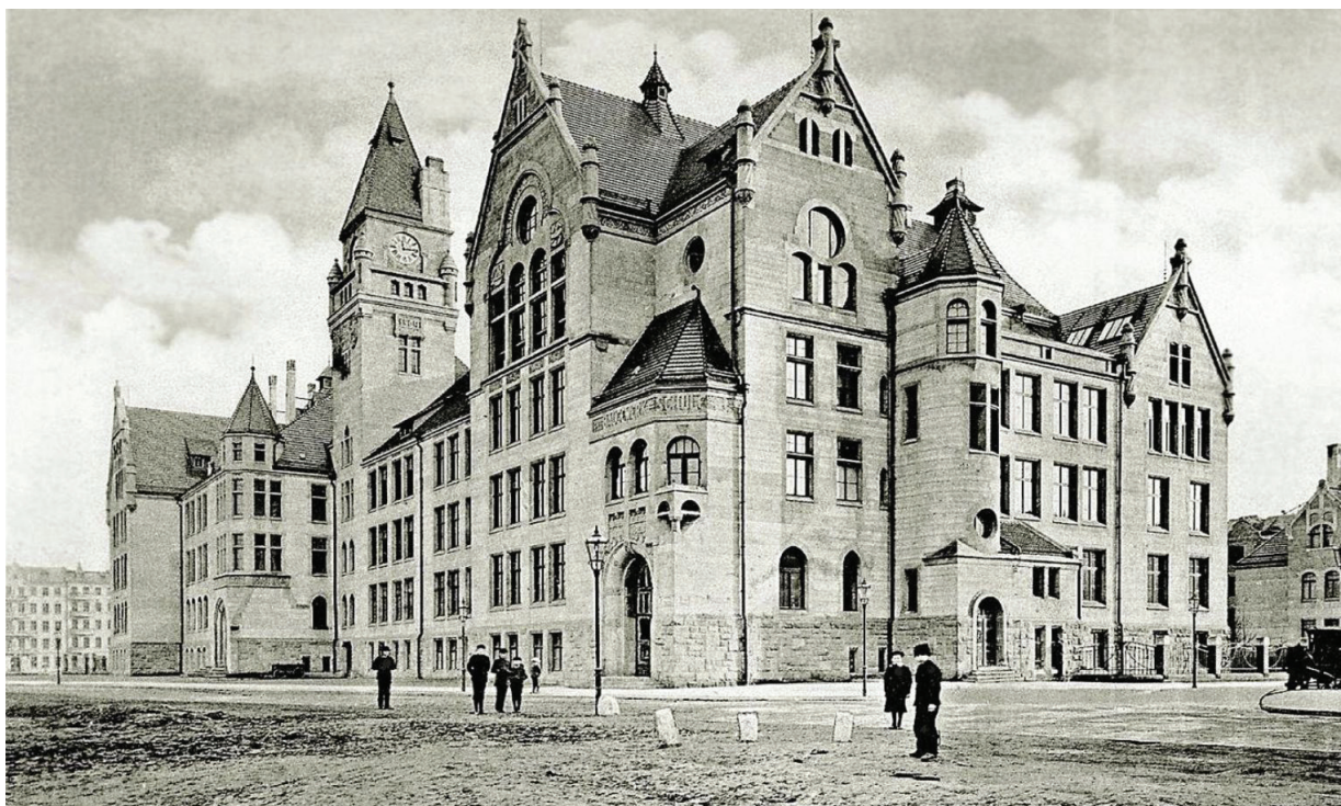
Il. 1. Königl. Baugewerk- und Maschinenbauschule – Szkoła Rzemiosł Budowlanych i Wyższa Szkoła Budowy Maszyn. Projekt: arch. K. Klimm, założenia ideowe: arch. R. Plüddemann. Stan z 1904 r. (źródło: Archiwum Państwowe we Wrocławiu, Akta m. Wrocławia, sygn. 2677)
