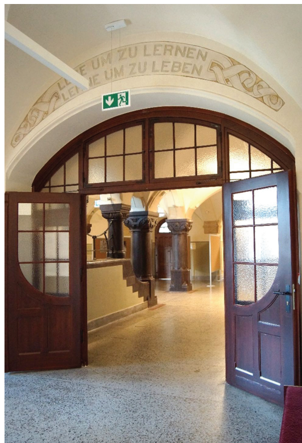
Il. 12. Gmach Wydziału Architektury Politechniki Wrocławskiej. Korytarz i hol na pierwszym piętrze. Oryginalne oszklone drzwi korytarza po renowacji, wyposażone w system blokad i samozamykaczy przeciwpożarowych. Odtworzony napis sztukatorski (fot. A. Krupa, 2019)
