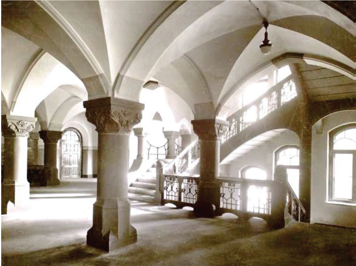
Il. 2. Wnętrze holu Szkoły Rzemiosł Budowlanych, arch. K. Klimm (fot. E. van Delden, H. Götz, 1905) (źródło: Biblioteka Uniwersytecka we Wrocławiu, Oddział Zbiorów Graficznych)
