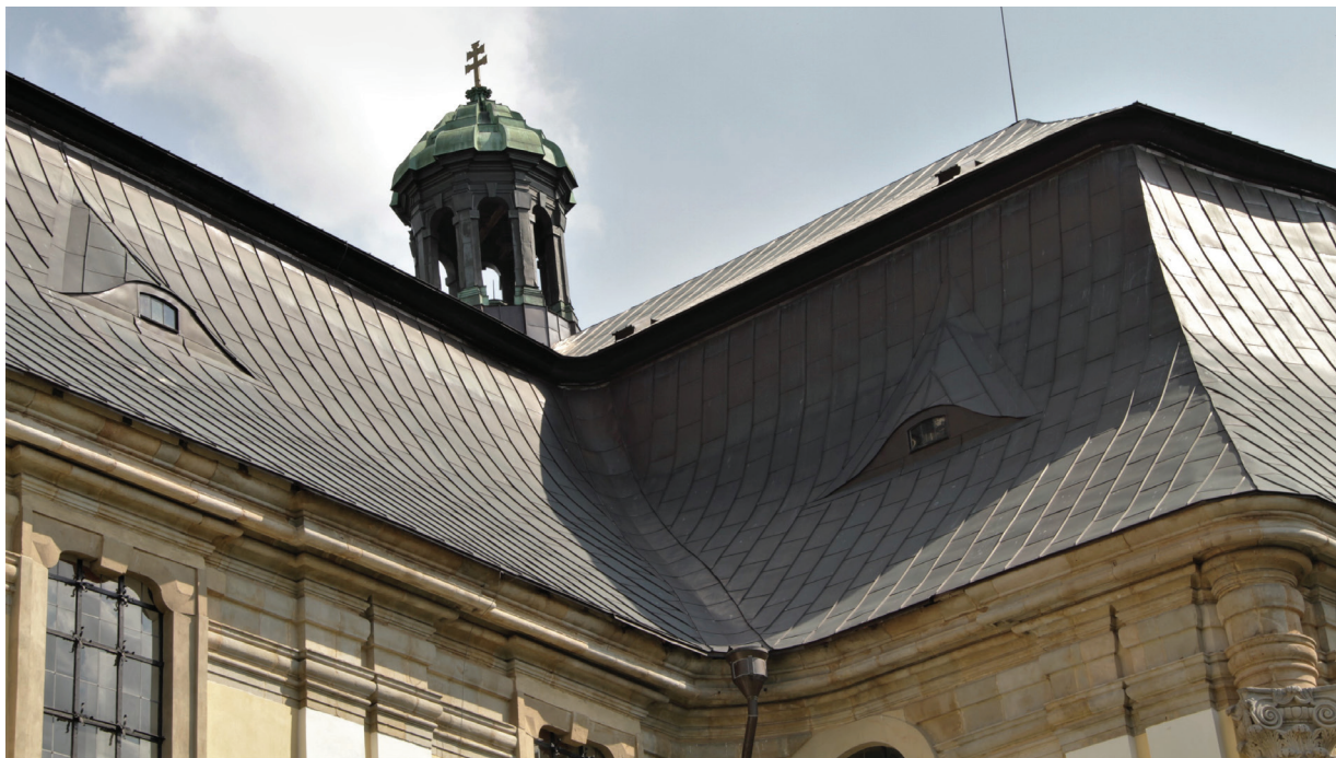
Il. 7. Krzeszów, dachy nawy południowej i transeptu (fot. M. Dąbkowska)
