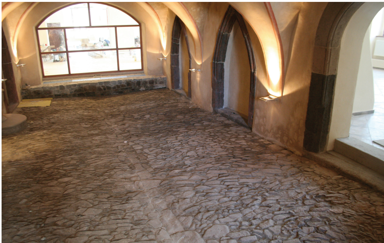
Il. 6. Głubczyce, blok ratuszowy, przejście sukiennicze, widok ściany zachodniej i bruk z kamienia łamanego, stan po pracach (fot. A. Legendziewicz)
