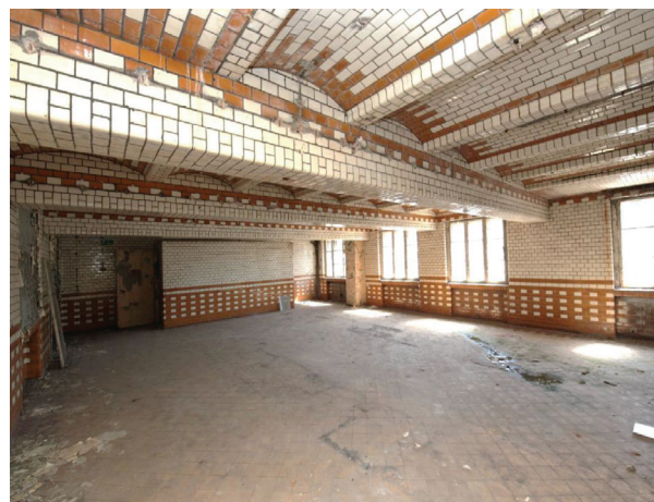
Il. 16. Szatnie personelu na 2. piętrze budynku produkcyjnego piekarni wzniesione w 1907 r. Na ścianach i na stropach odcinkowych zachowane dwubarwne, ceramiczne lico. Zachowana posadzka ceramiczna oraz okna drewniane (fot. M. Lamber, 2017)
