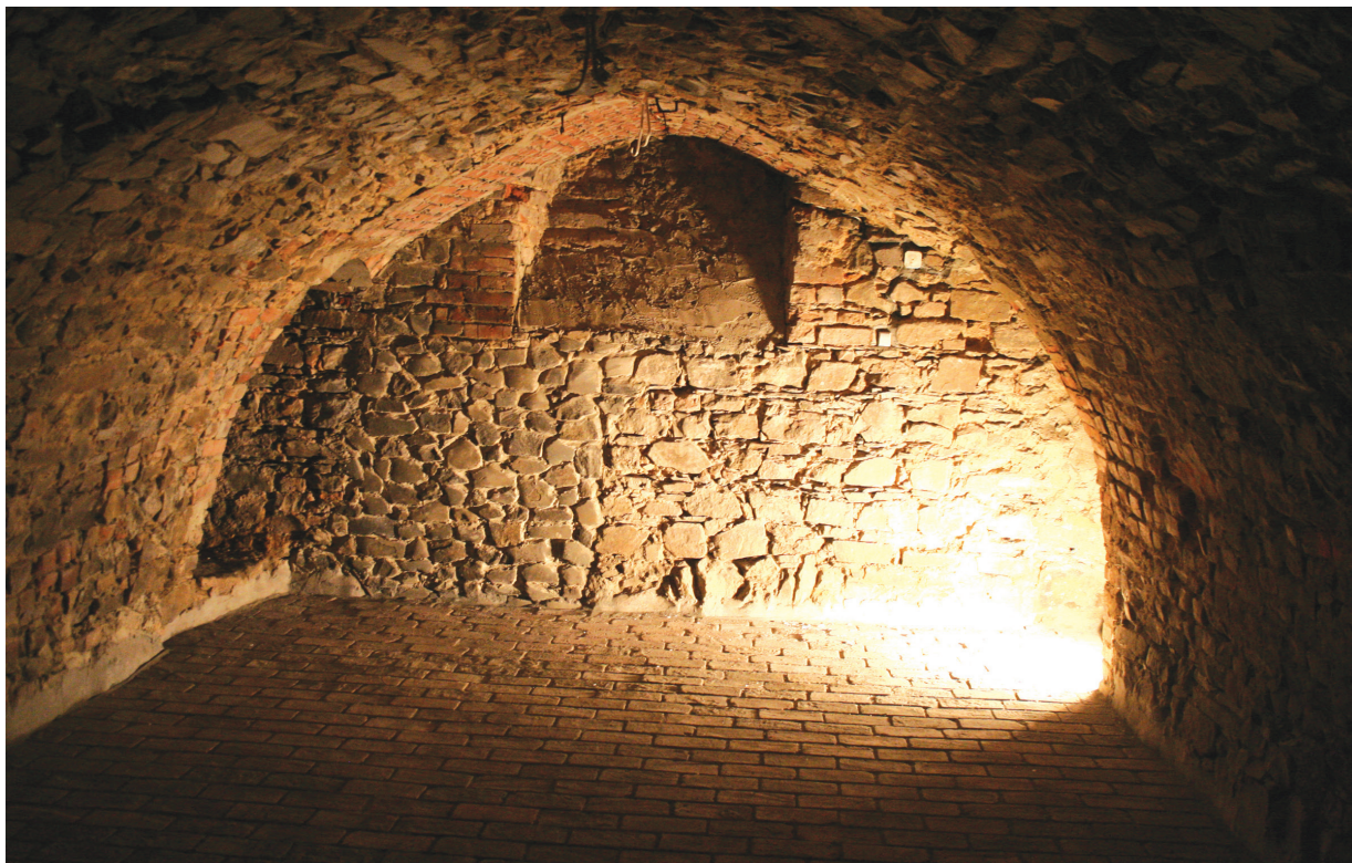
Il. 11. Głubczyce, blok ratuszowy, piwnica kramu drugiego od północy, widok wnętrza ku wschodowi i posadzka, stan po pracach (fot. A. Legendziewicz)
