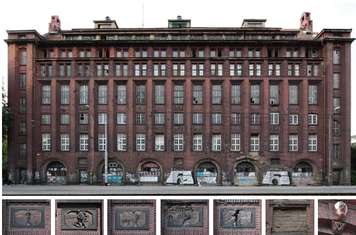
Il. 9. Widok fasady budynku magazynu mąki przy ul. Sienkiewicza 18–22 we Wrocławiu oraz wybrane detale tej elewacji.
