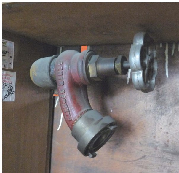
Il. 9. Hydrant wñkowy w budynku Miejskiej Kasy Pożyczkowej (fot. P. Kirschke, 2013)
