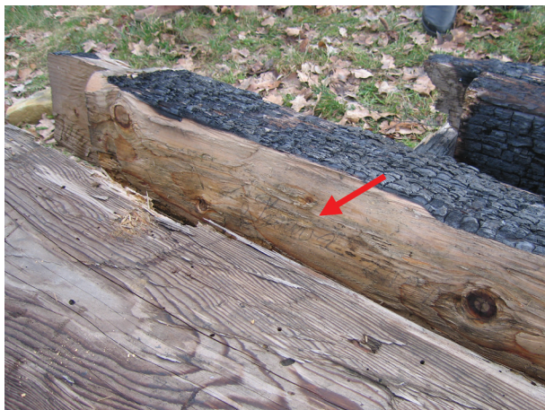
Il. 1. Pogorzelisko po XVII-wiecznym kościele w Grabówce – odnalezienie inskrypcje na belkach konstrukcyjnych ścian (fot. D. Mączyński)
