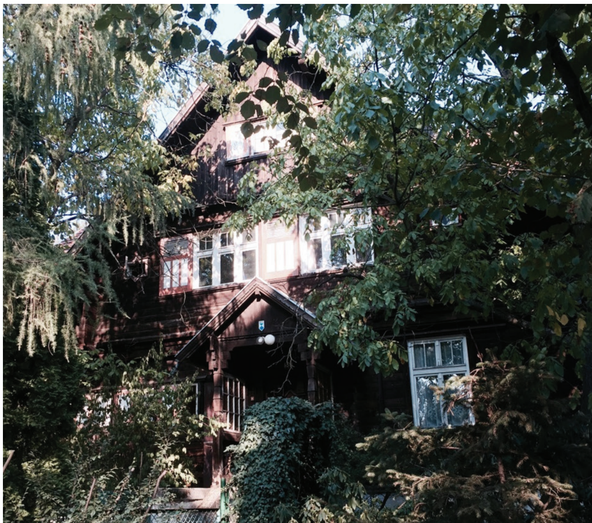
Il. 10. Willa przy ul. Chopina – elewacja frontowa z gankiem w konstrukcji drewnianej, w którym znajduje się wejście główne do obiektu (fot. J. Olesińska)
