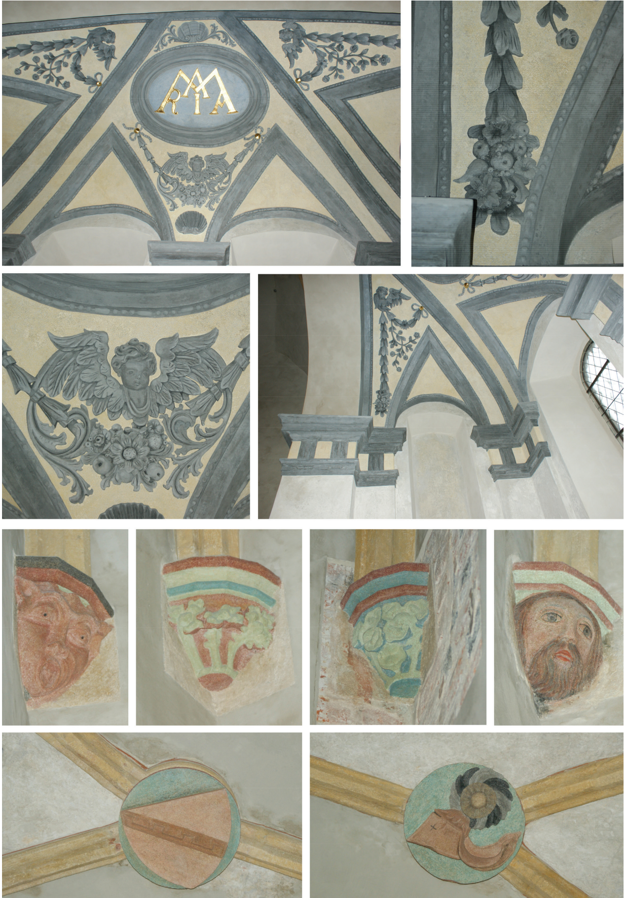
II. 8. Detale kaplicy. Stan po konserwacji (fot. L. Smirnowa)
