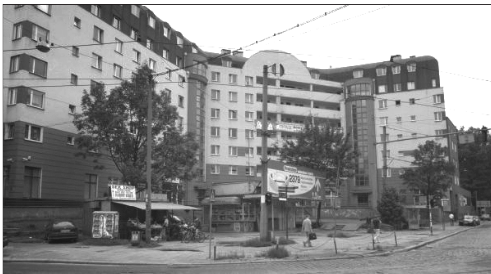
Ryc. 11. Partery budynków na „pl. Pułaskiego” we Wrocławiu (fot. M. Natusiewicz)
