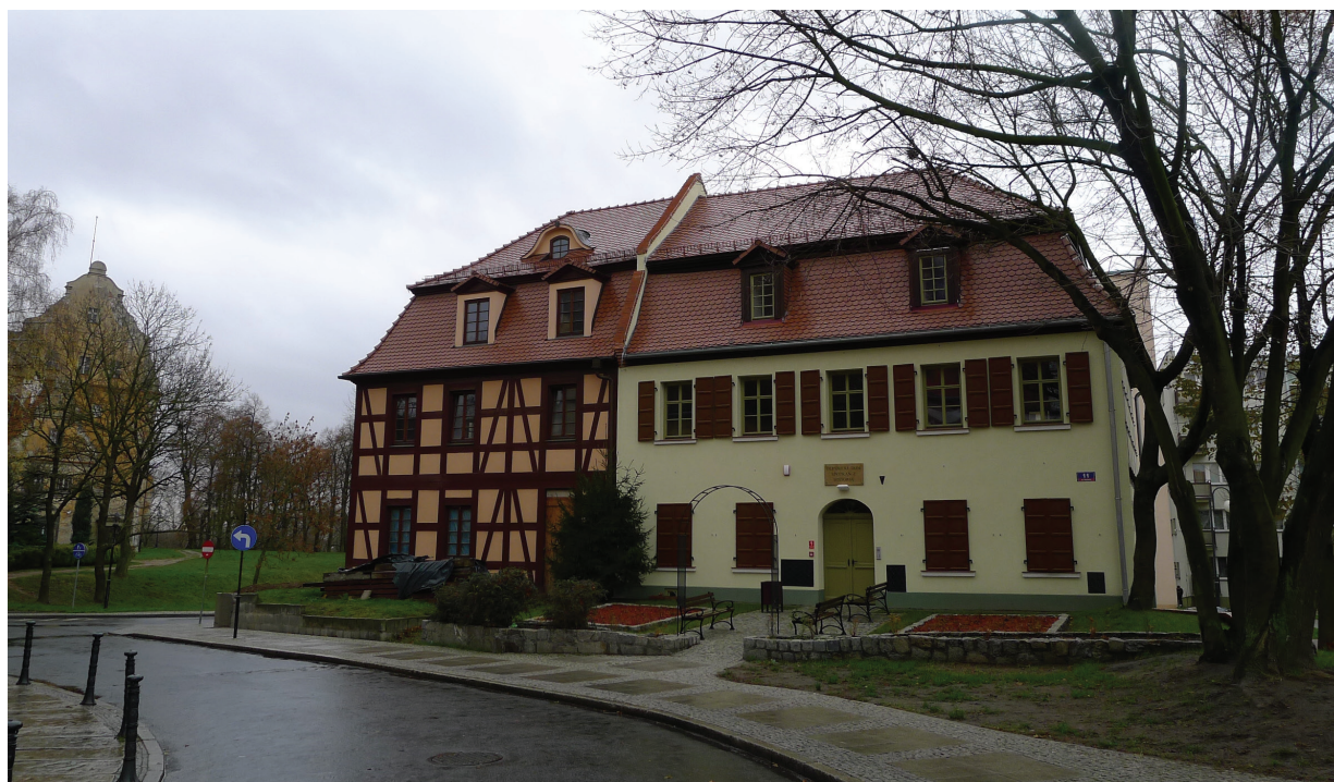
Il. 6. Budynki nr 11 i 12 przy ul. Bocianiej w Oleśnicy po pracach remontowych, widok od frontu (fot. M. Małachowicz)
