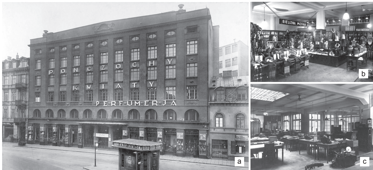
Il. 2. Dom Towarowy Bracia Jabłkowscy przy ul. Brackiej 25 w Warszawie: a) fasada, b), c) wnętrza działu handlowego i biura z widoczną żelbetonową konstrukcją (arch. F. Lilpop i K. Jankowski, 1914) (ilustracje ze zbiorów DTBJ S.A., Warszawa, ul. Chmielna 21)
