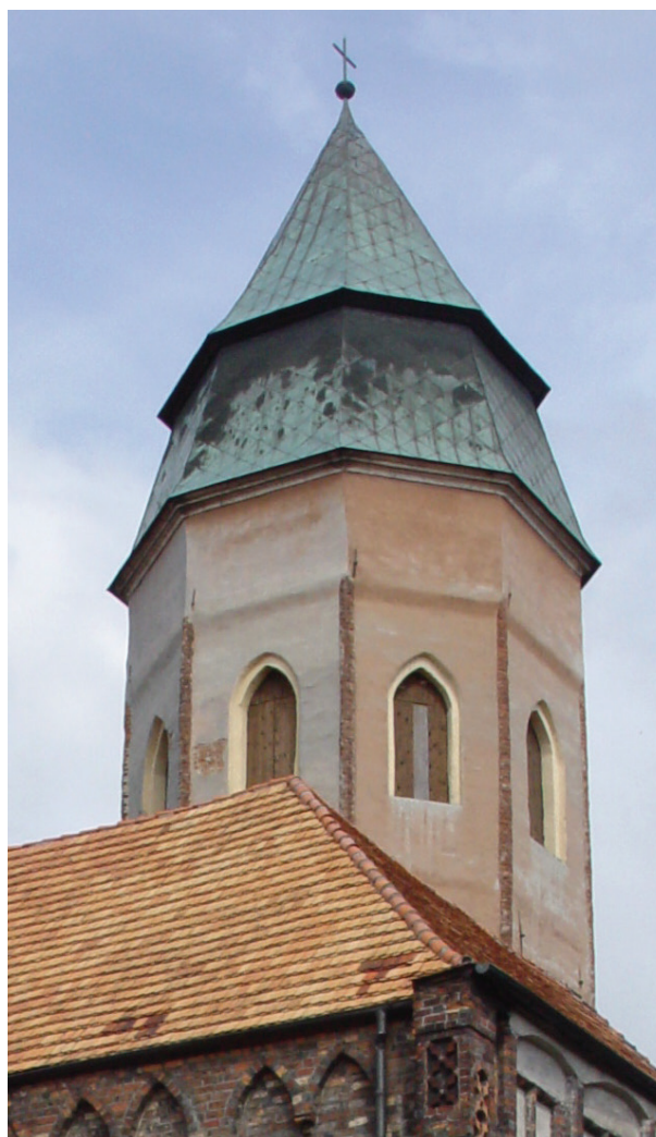
Il. 2. Koźuchów, wieża kościoła pw. MB Gromnicznej, stan sprzed prac (fot. A. Legendziewicz)
