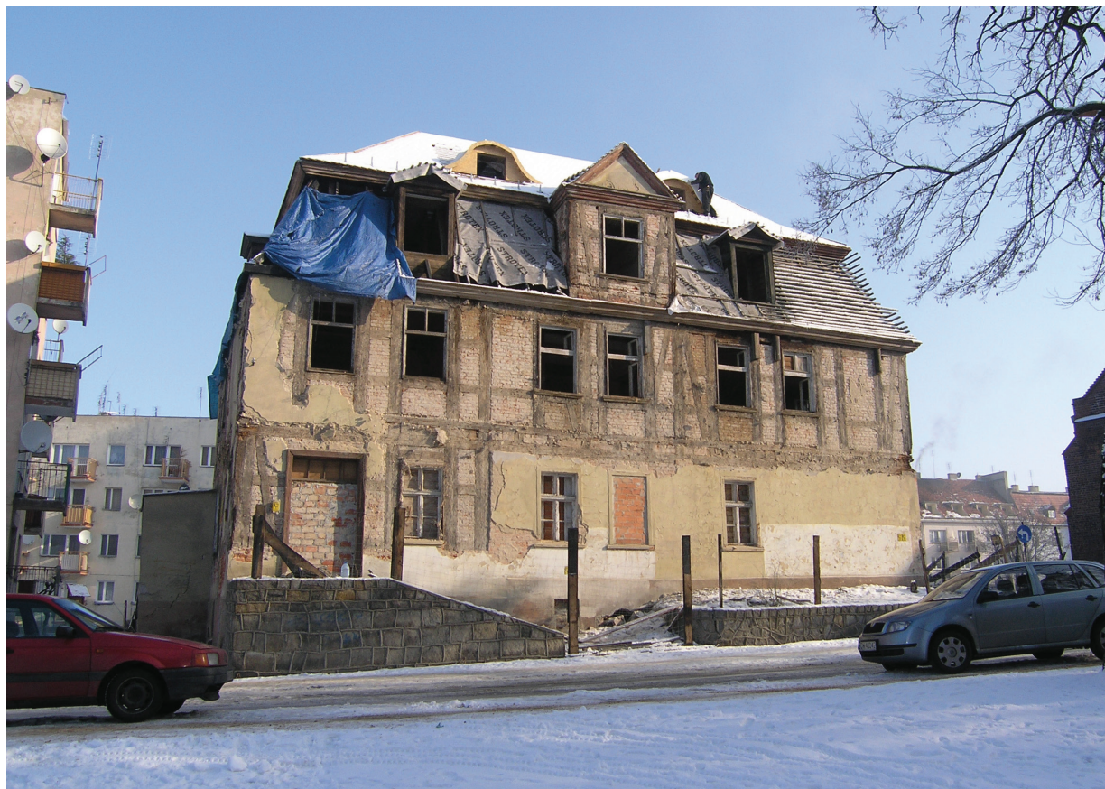
Il. 5. Budynek przy ul. Bocianiej 12 z odsłoniętą zabytkową konstrukcją (fot. M. Małachowicz)
