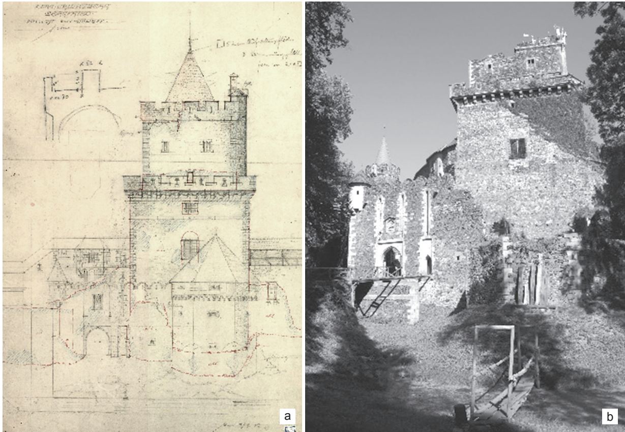
II. 6. Donjon oraz brama wjazdowa na zamek górny: a) koncepcja odbudowy, Bodo Ebhardt 1907 r. (zbiory Europäisches Burgeninstitut – Einrichtung der Deutschen Burgenvereinigung e.V. [Braubach]; DBV-Archiv, Sammlungen Gröditzburg); b) wygląd po przeprowadzeniu prac przez Ebhardta, stan obecny (fot. A. Marcinów, 2017)
