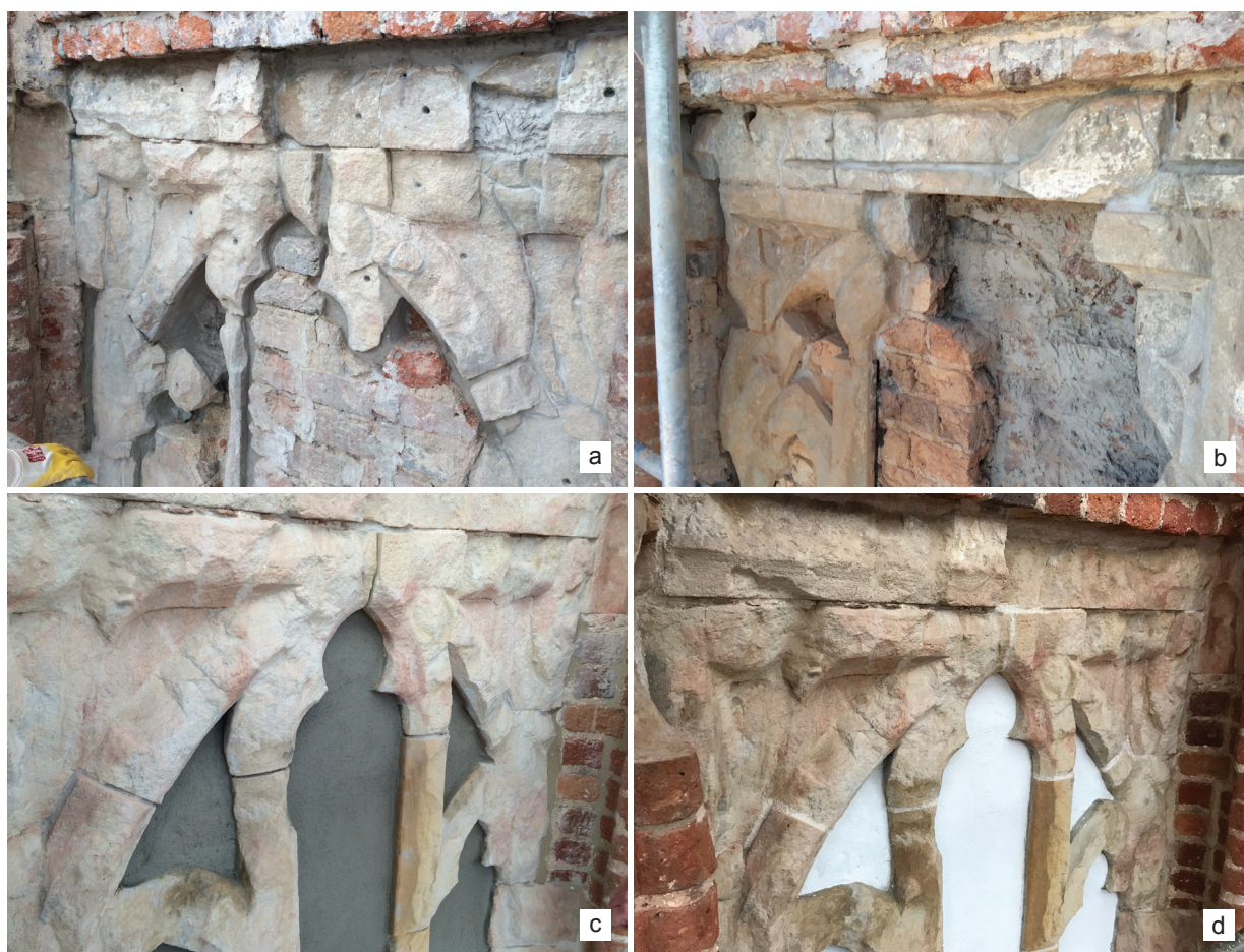
Il. 7. Koźuchów, kościół pw. MB Gromnicznej, wieża, maswerk drugiej kondygnacji ośmioboku; stan: a – po skuciu tynków, b – po usunięciu części przemurowań, c – po wykonaniu uzupełnień i tynków na zamurowaniu, d – po zakończeniu prac (fot. A. Legendziewicz)
