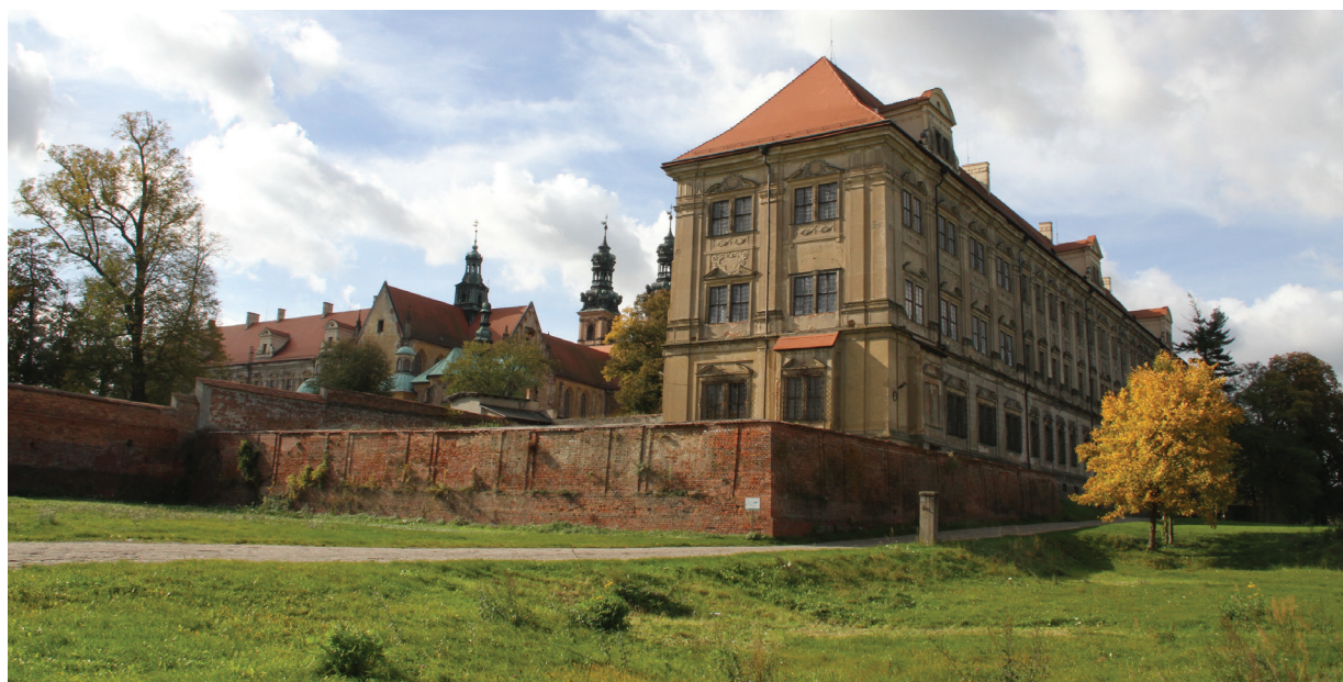
II. 6. Lubiąż, widok na pałac opata i kościół od północnego wschodu (fot. M. Dąbkowska)
